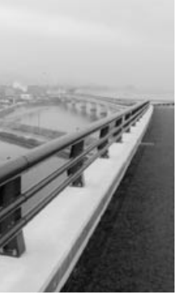
▲形原漁港大橋 (ブルーブリッジ)
