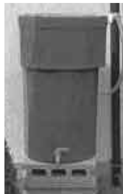
▲雨水利用簡易貯留槽
