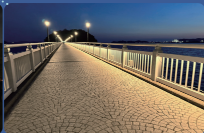
竹島橋手すり 間接照明の様子
