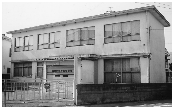
宮成防災倉庫
