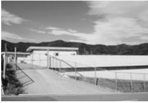
清田低区配水場
