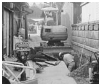
西浦町地内下水道工事
