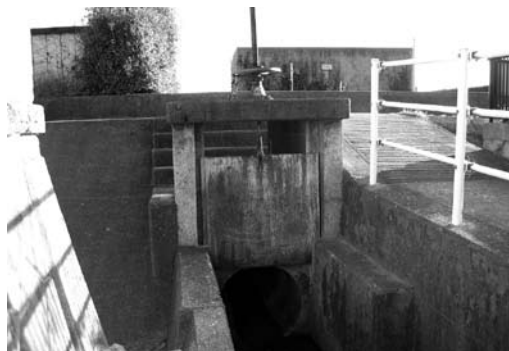
宮川河口樋門
