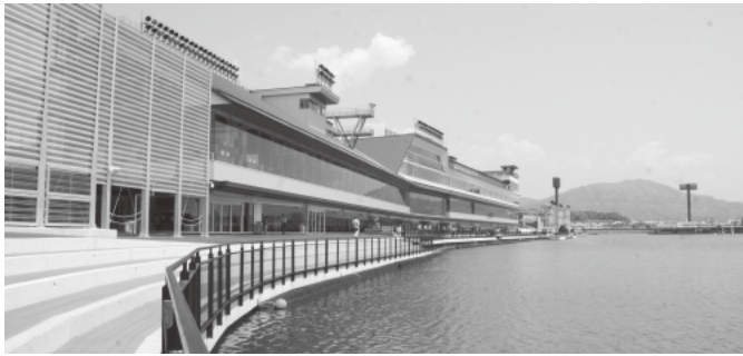
4月26日にオープンしたボートレース蒲郡新スタンド
