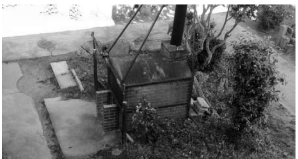
学校の小型焼却炉
