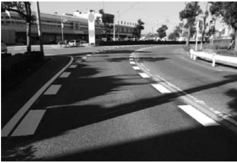
竹島水族館前に新設された破線の路面標示
