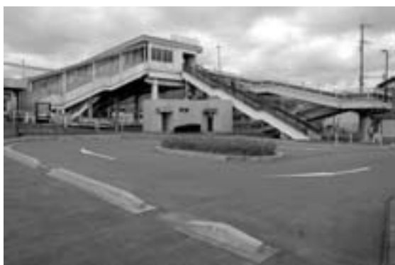
整備を行う塩津駅前広場
