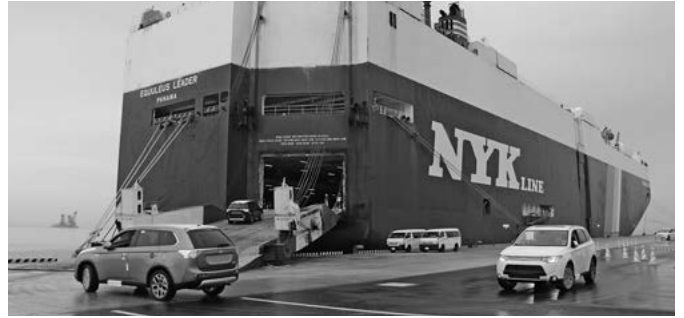
背後地が未整備の11号岸壁
