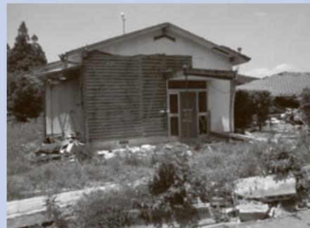
外壁が落ち、ブロック塀も倒壊した家屋
