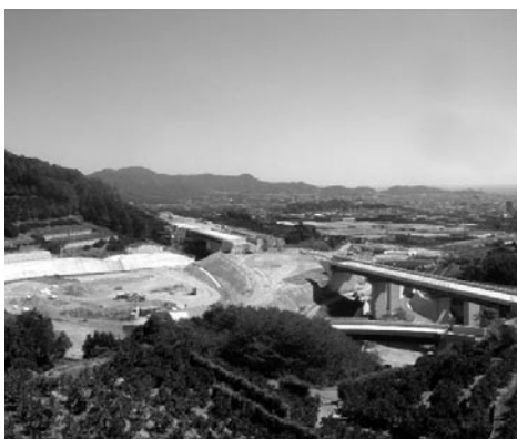
工事が進められる蒲郡西IC（仮称）
