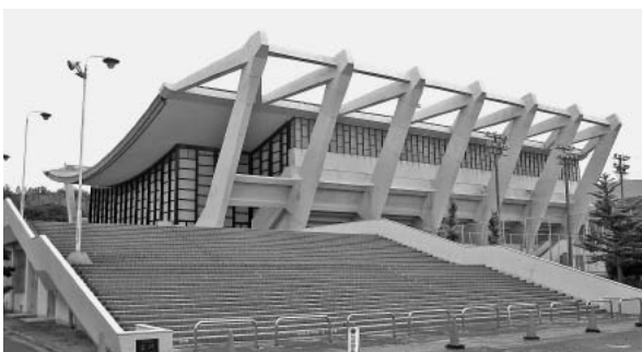
建て替えを検討する体育館
