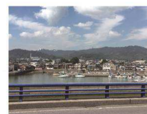
形原漁港大橋から見る船溜まり
