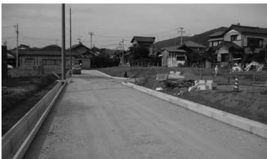
現在進捗中の中部土地区画整理
