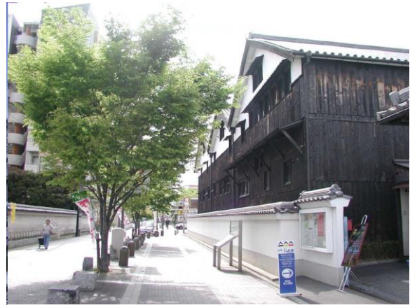
白雪ブルフリービレッジ長寿蔵（兵庫県伊丹市）
