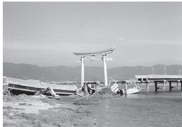
伊勢湾台風で崩れた竹島橋
