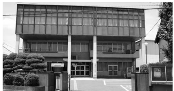
西部防災センター
