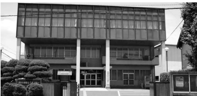
センター廃止後は、防災倉庫転用が考えられている西部市民センター
