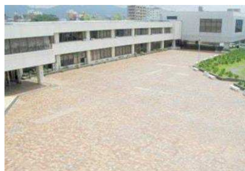
屋外高床広場
