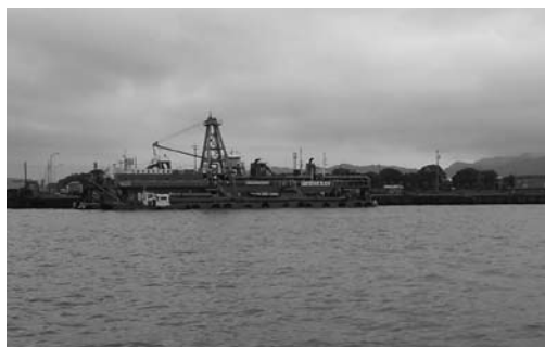
試験掘削に伴い活用が期待される蒲郡港
