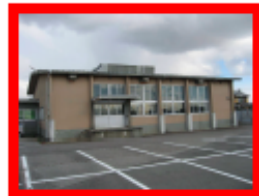
吉良防災倉庫 →施設解体
