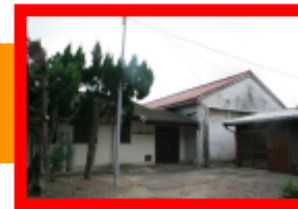
横須賀老人憩の家ホール棟
