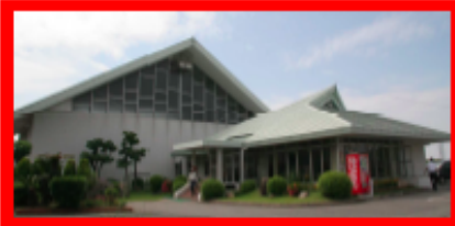
吉良野外趣味活動施設 →施設解体
