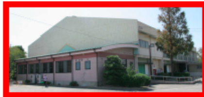
コミュニティ公園体育館 →施設解体（管理棟含む）
