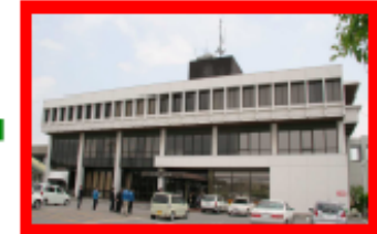
吉良町公民館 →施設解体
