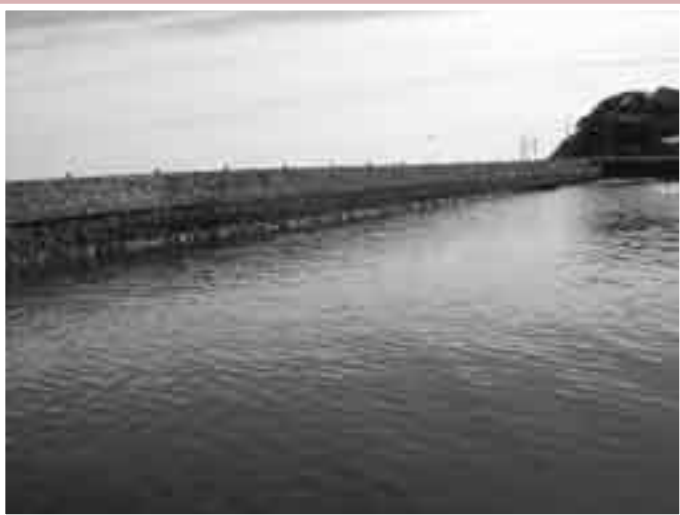
▲稲生港石積防波堤
