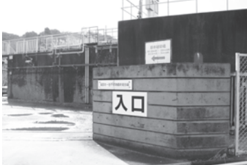
一色不燃物最終処分場
