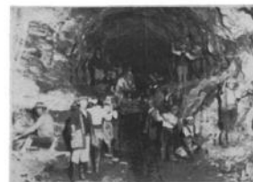
工事中の斜地坂トンネル(昭和6年頃)
