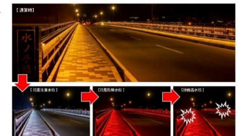
光の色変化によって水位を知らせる防災アラートシステム（水の手橋 熊本県人吉市）
