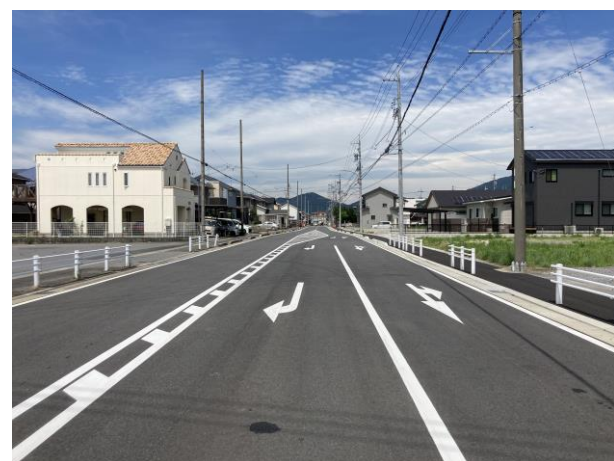
道路整備状況写真 (蒲郡環状線)
