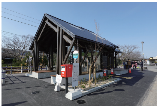
▲完成した西浦駅待合所
