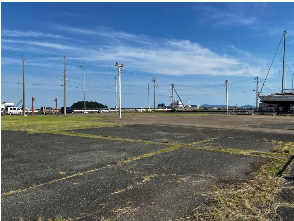
交流スペース 南東側広場
