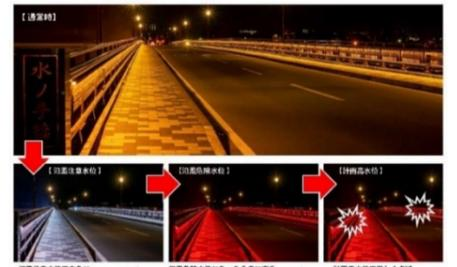
光の色変化によって水位を知らせる防災アラートシステム（水の手橋 熊本県人吉市）
