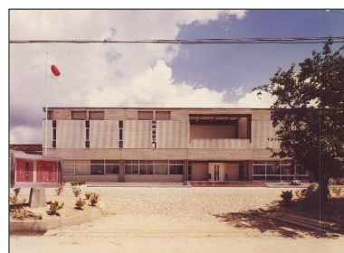
昭和 44 年 7 月 竣工時の図書館
