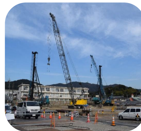
学校複合施設建設工事現場 （12月上旬撮影）
