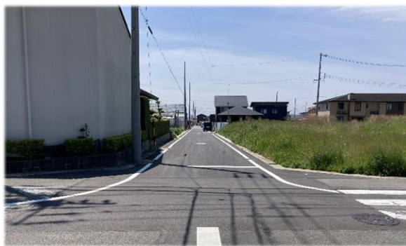
舗装整備状況写真 (区画道路)
