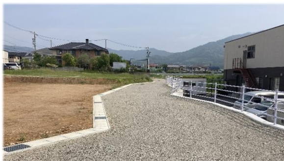
側溝・擁壁整備状況写真 (区画道路)
