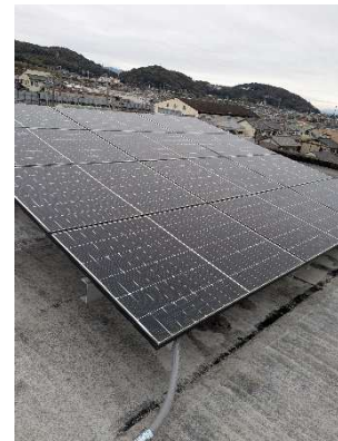
（公共施設への太陽光パネルの設置）
