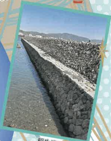
稲生港石積防波堤
