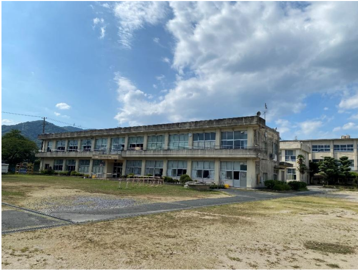
図 2-2-b 既存校舎（管理・教室棟）の現況写真
