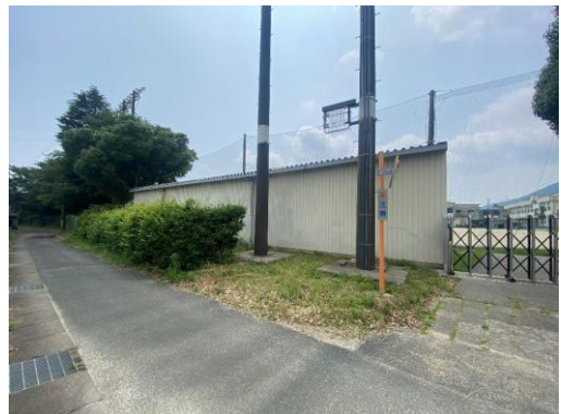
図 2-1-h 小学校と東側道路
