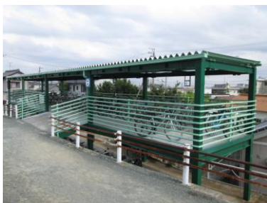
大塚駅第1自転車駐車場
