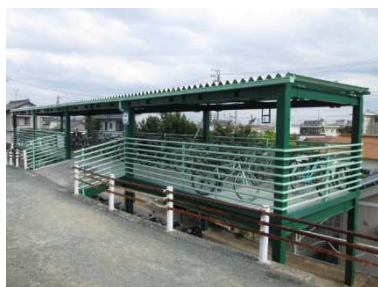
大塚駅第1自転車駐車場
