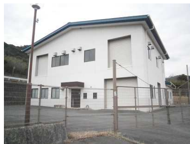
一般廃棄物最終処分場
