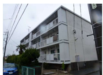
市営力川住宅
