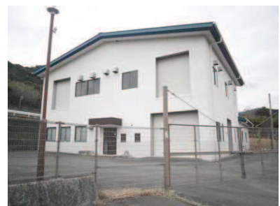
一般廃棄物最終処分場
