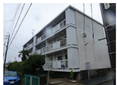
市営力川住宅
