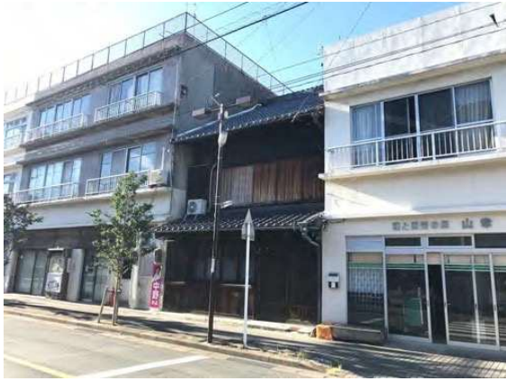
①銀座通り商店街は昭和30年代に建てられた防火帯建築が続きノスタルジックな街並みを形成しています。
