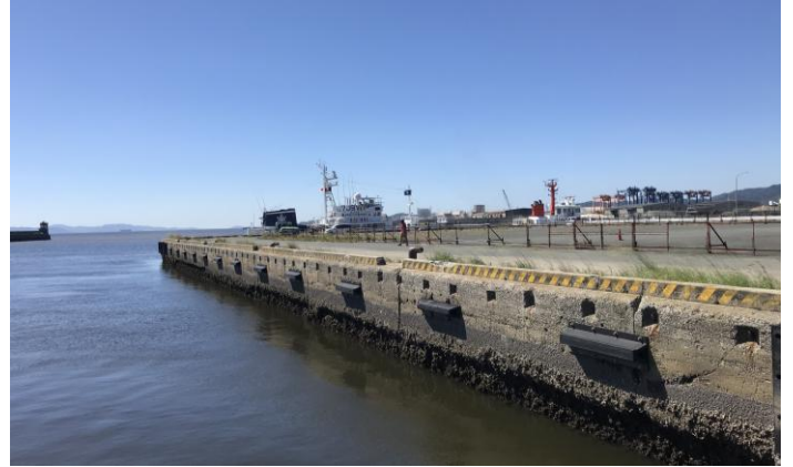
現況写真：3号岸壁側から竹島ふ頭を望む
