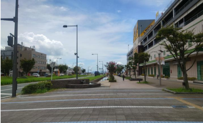
現況写真：駅から海方向を望む
