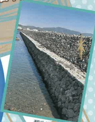
稲生港石積防波堤
