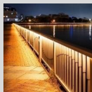
手すり間接照明
