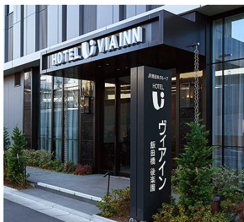
建物と一体の屋外広告
