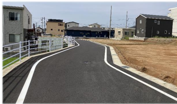
舗装整備状況写真 (区画道路)
