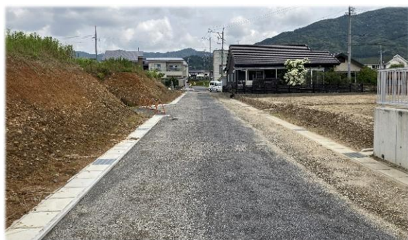
側溝・路盤整備状況写真 (区画道路)
