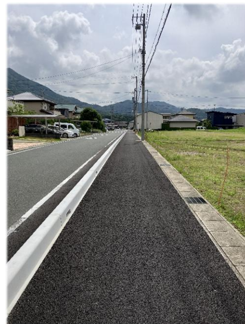
歩道整備状況写真 (区画道路)
