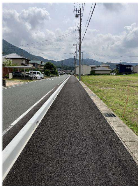
歩道整備状況写真 (区画道路)
