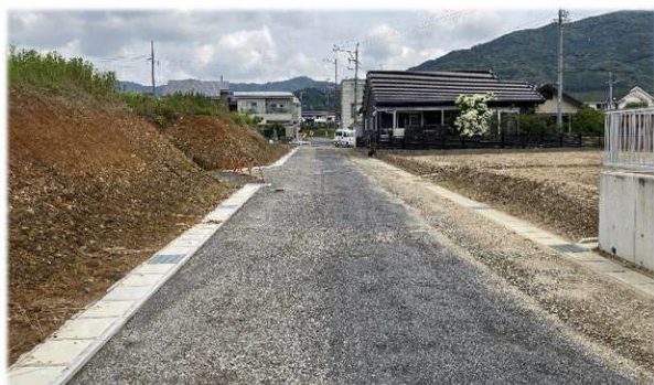
側溝・路盤整備状況写真 (区画道路)
