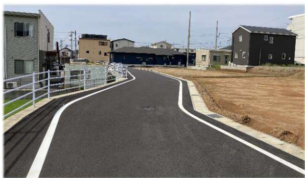
舗装整備状況写真 (区画道路)
