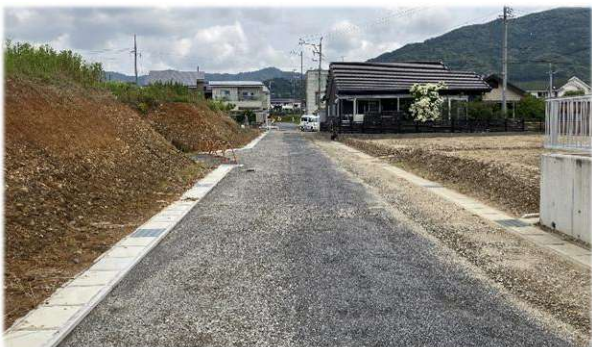
側溝・路盤整備状況写真 (区画道路)
