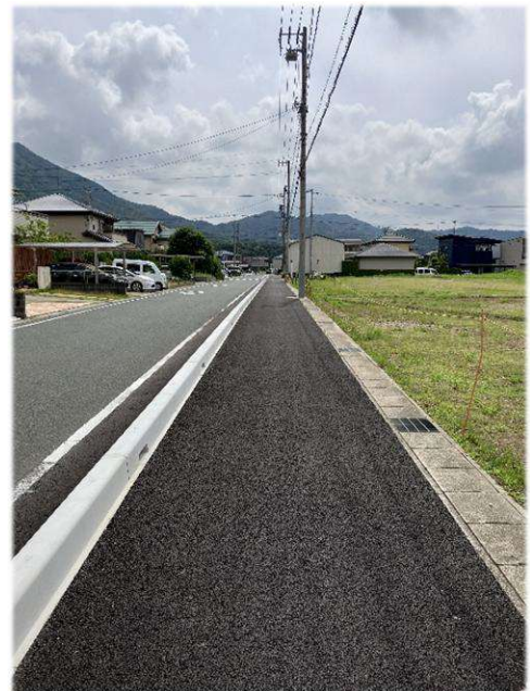
歩道整備状況写真 (区画道路)
