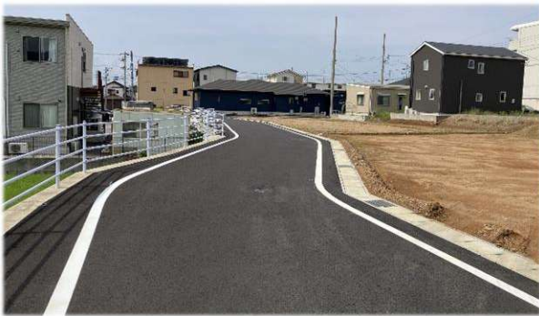
舗装整備状況写真 (区画道路)
