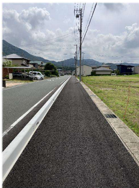
歩道整備状況写真 (区画道路)
